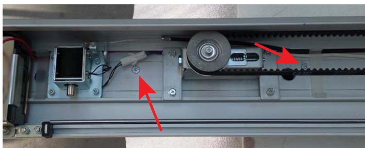
Para isso, basta desapertar os parafusos que prendem a parte frontal do cofre à parte traseira.
